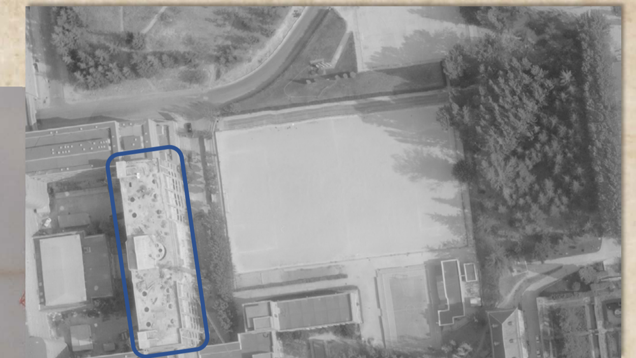
Facultad de Ciencias Químicas durante la construcción del edificio B (1983).
